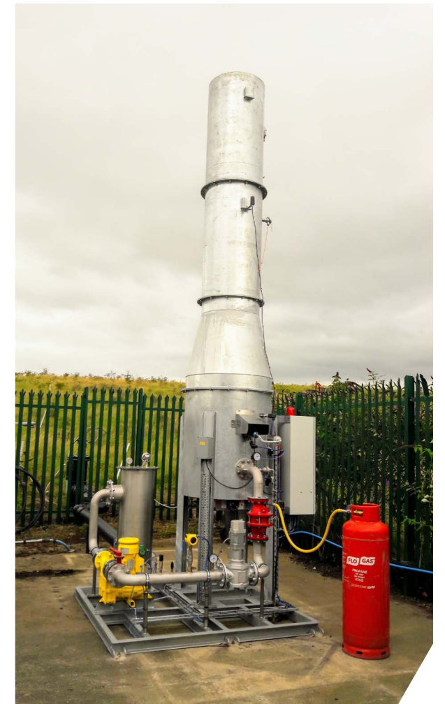
Sceitheoir bladhma ísealchalra suiteáilte ag Láthair Líonta Talún Dhroichead Átha.
