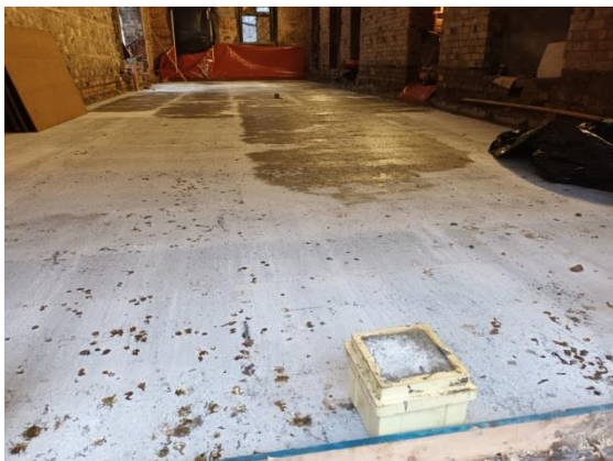
Concrete Floor Pour Block B
